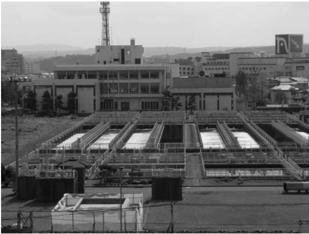
写真2 八戸市下水処理場
