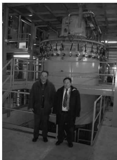
写真1 オーストリアの電力会社によるガス化実証試験装置 (5000kW相当)
