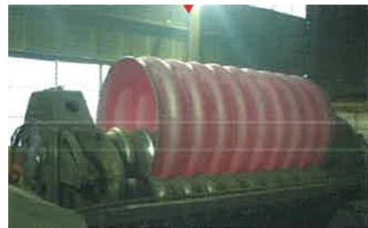
図 23 熱間ローラによる波型炉筒製作 ((株)ヒラカワの資料による)
