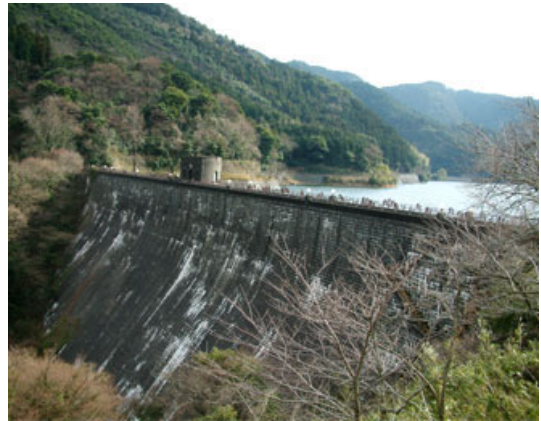
河内ダムと貯水池
