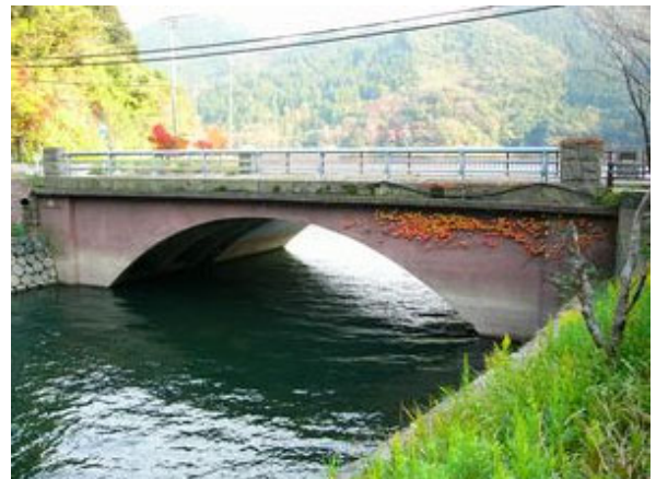
鉄骨コンクリート橋の 北河内橋
