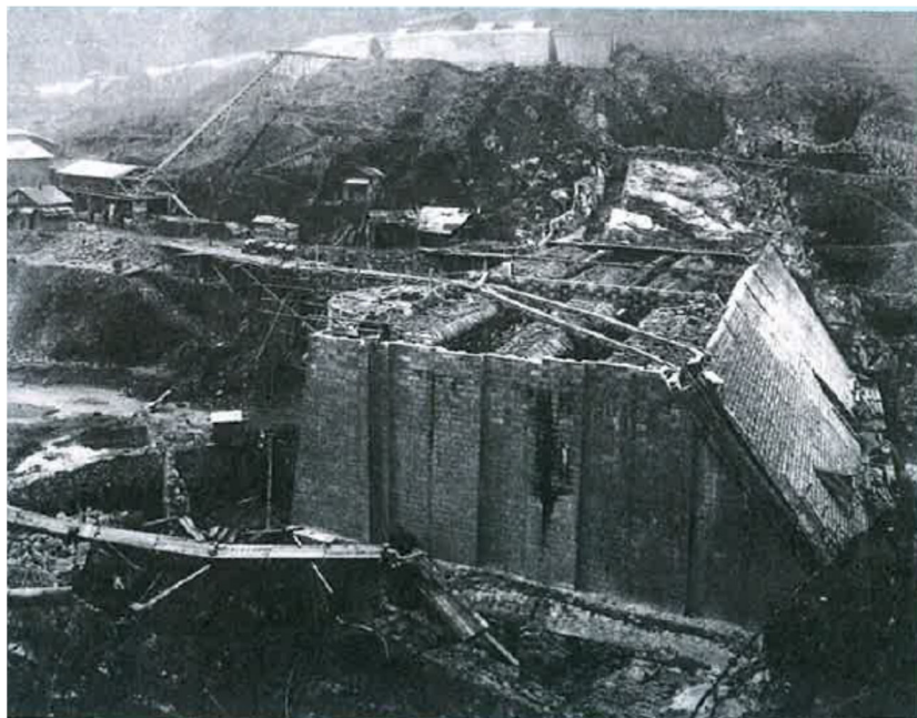
河内ダム建設現場（新日本製鐵株八幡製鐵所提供）
