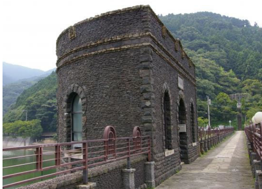
河内ダム上の取水塔
