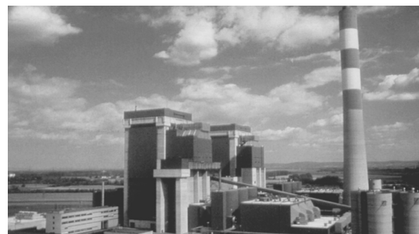
Fig. 2 完成したDuernrohr発電所 （写真提供：EVN）
