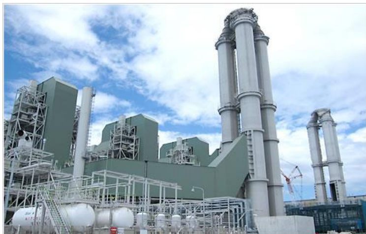
関西電力株式会社 姫路第二発電所
