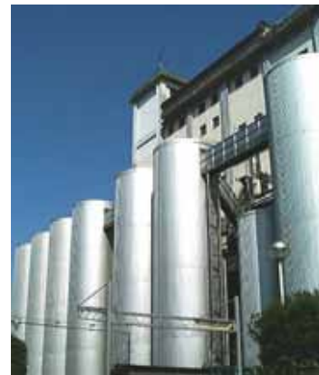
図6 大型発酵タンク
