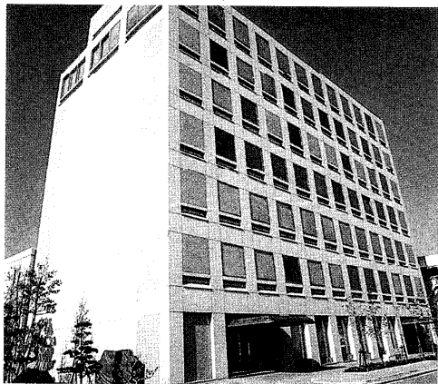
図1 ダイキン工業機械技術研究所外観
